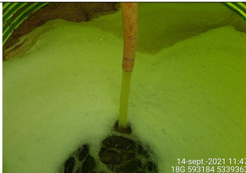
Fotografía N°2: Retiro de Lixiviados desde diagonal D2 por Personal Municipal. Tomada: Martes 14 de Septiembre del 2021.
