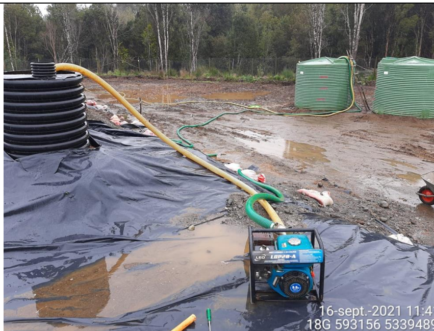
Fotografía N°6: Extracción de Lixiviados desde diagonales C10 por Personal Municipal. Tomada: Jueves 16 de Septiembre del 2021
