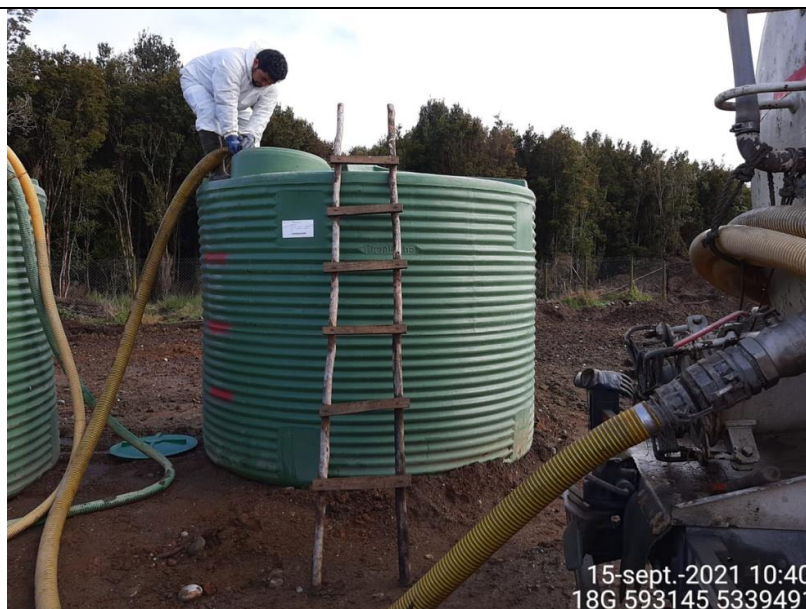
Fotografía N°4: Extracción de Lixiviados de estanques de acumulación por Aconser.
