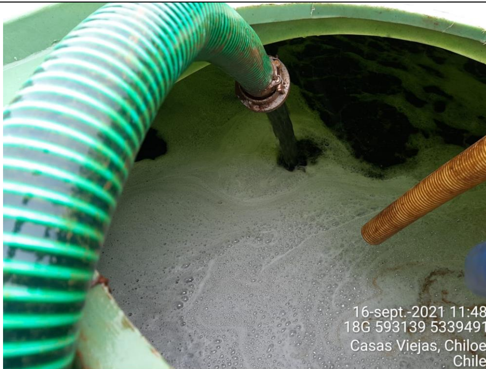
Fotografía N°8: Retiro de Lixiviados a estanque de acumulación por Personal Municipal. Tomada: Jueves 16 de Septiembre del 2021
