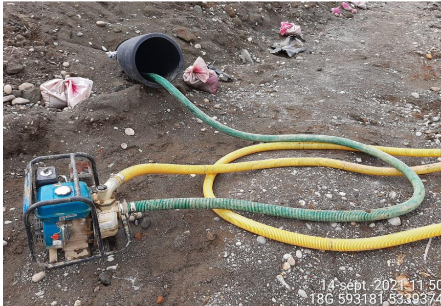
Fotografía N°1: Retiro de Lixiviados desde diagonal D2 por Personal Municipal. Tomada: Martes 14 de Septiembre del 2021.
